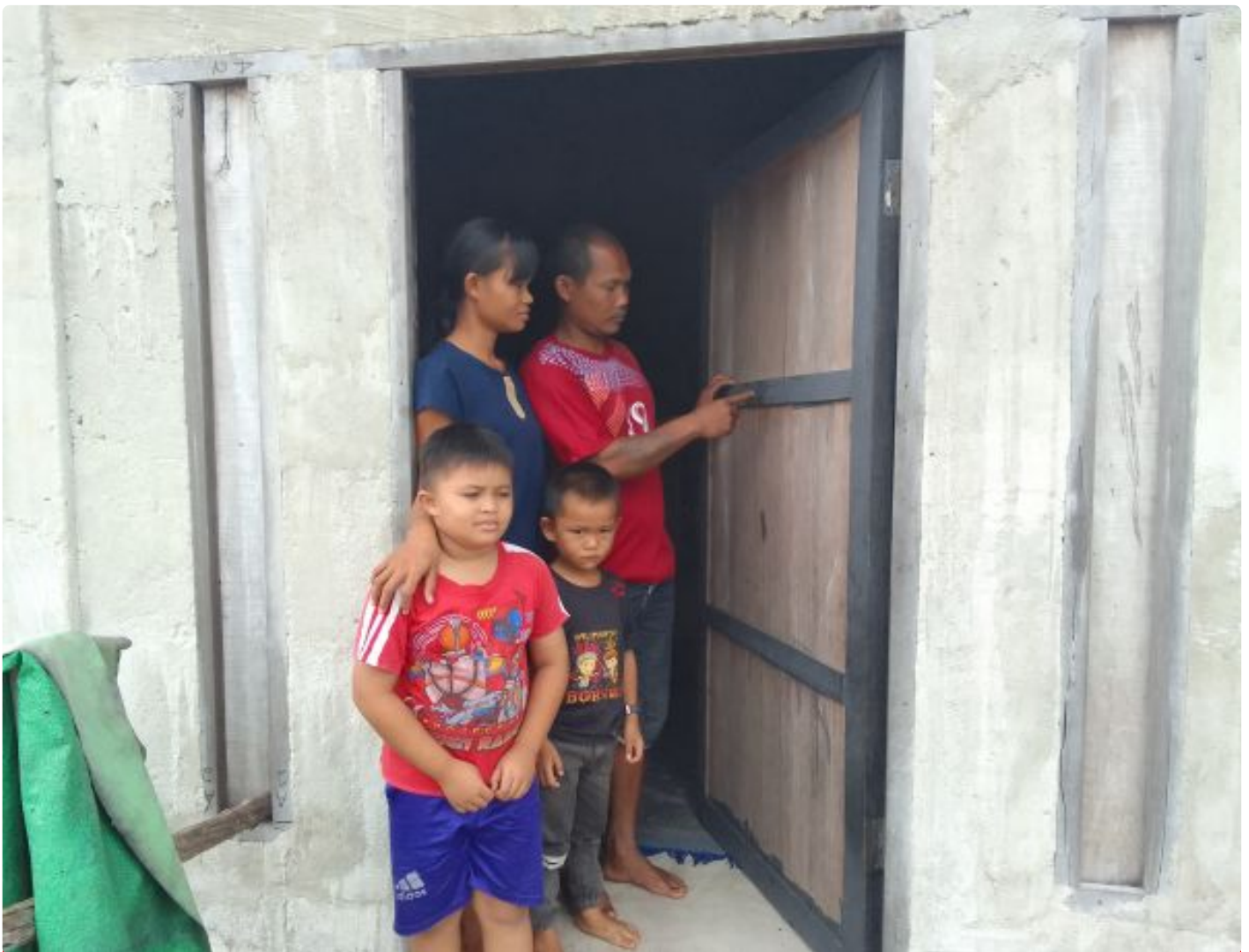
Warga Menunjukkan Bekas Peluru Nyasar Yang Telah Mengenai Pintu Rumahnya
